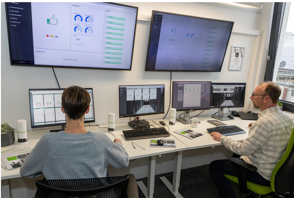
Operation Center mit KentixONE für die Rechenzentren der Heidelberg iT
