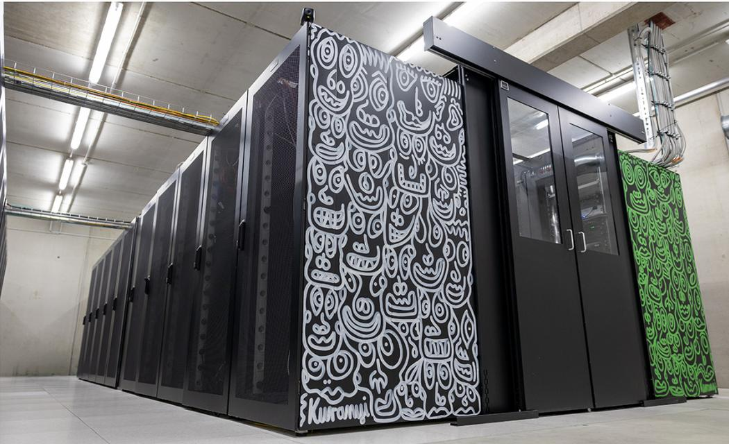
Kaltgangeinhausung mit lückenloser Überwachung über Kentix MultiSensoren und SmartPDU
