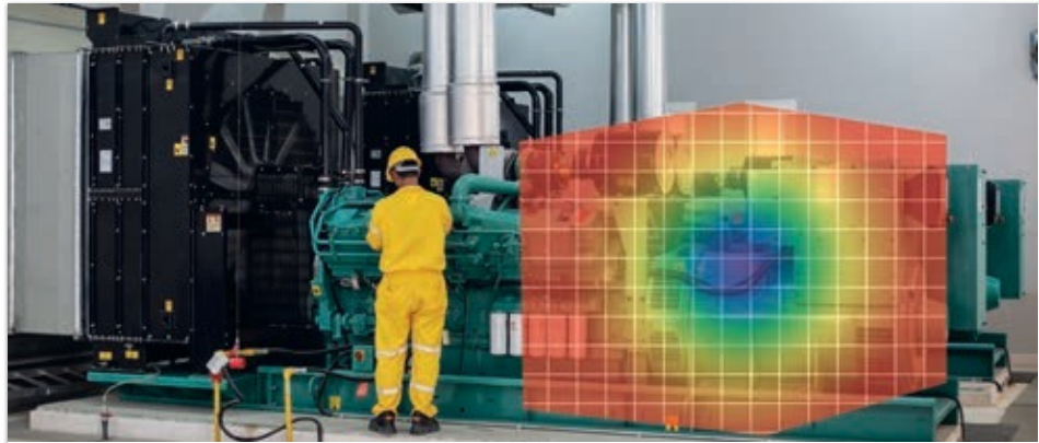
Generatoren, Aggregate, Elektroanlagen
