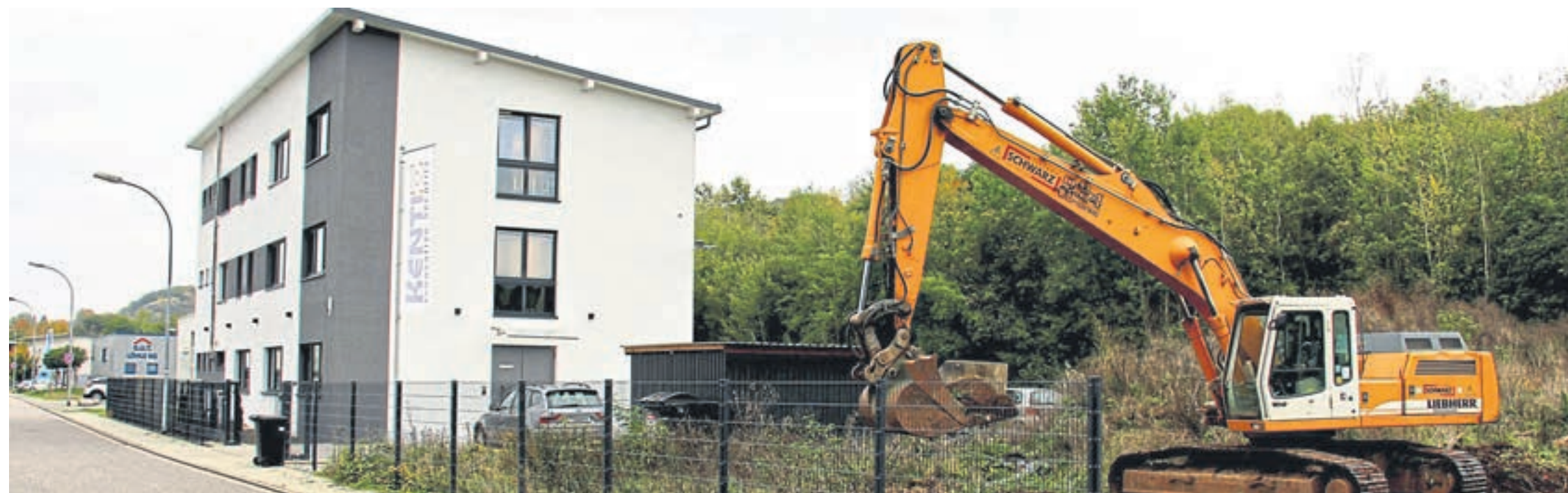
Kentix hat den Bau einer neuen Produktionshalle mit einer Größe von 800 Quadratmetern begonnen, um der gewaltigen Nachfrage gerecht werden zu können.
